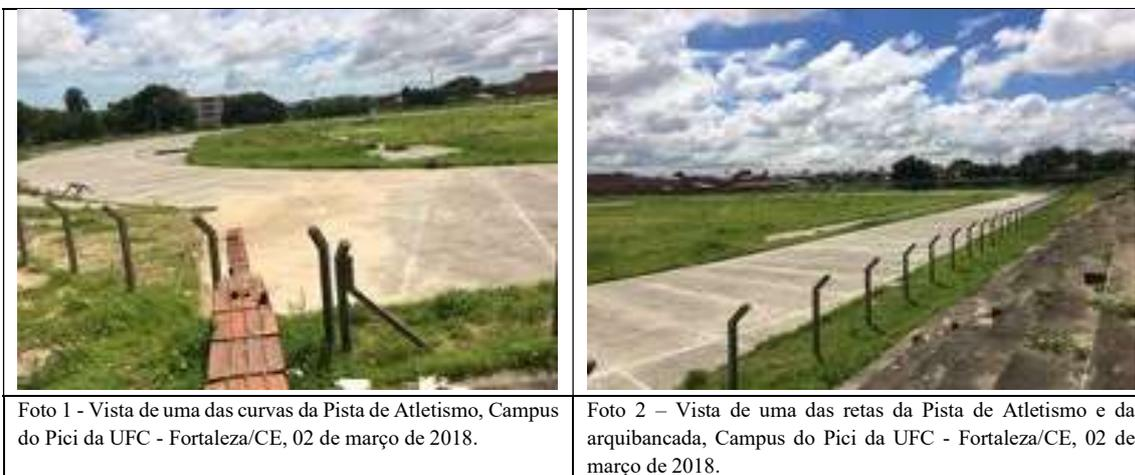
Ressalte-se que, conforme informações do Coordenador do IEFES, existe um defeito de inclinação na pista que impediu, por parte da empresa contratada, a colocação da cobertura.
