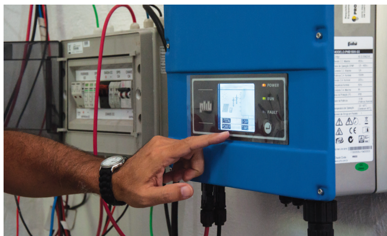
O Prof. Paulo Carvalho mostra os painéis solares e o equipamento eletrônico que transforma corrente contínua em corrente alternada
