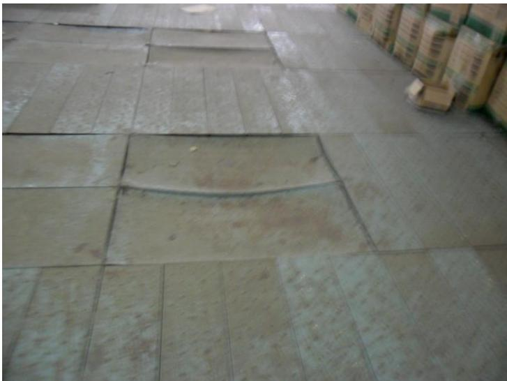
Constatação 10 – piso da plataforma metálica com deformações
