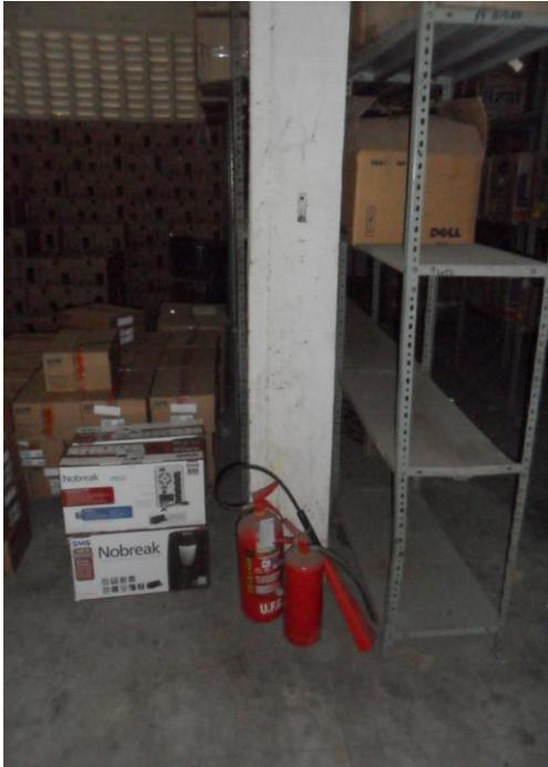
Constatação 3 – Distribuição espacial inadequada de extintores
