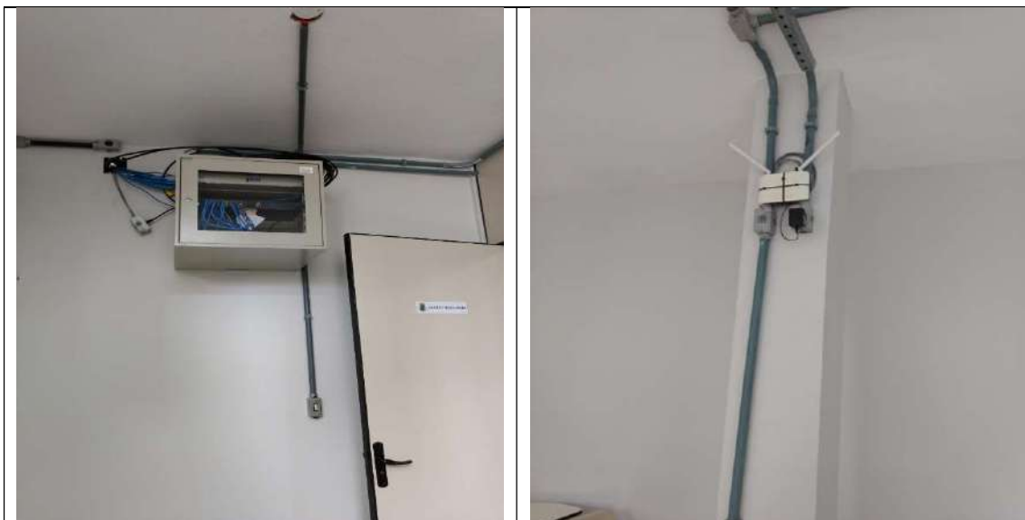
Rede lógica instalada e internet em funcionamento
