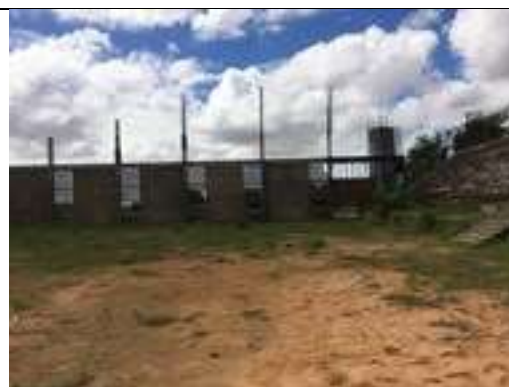
Foto 2 – Interior do Ginásio, Campus do Pici da UFC – Fortaleza/CE, 02 de março de 2018.
