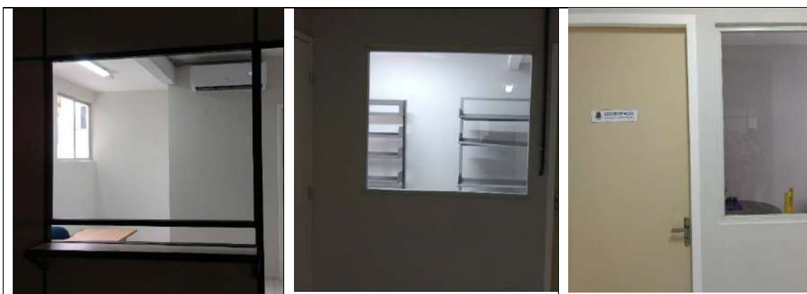
Gabinetes com divisórias, vidros, e ar condicionados em funcionamento
