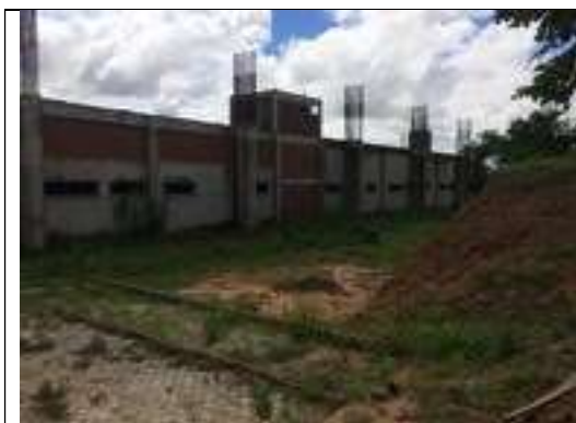
Foto 1 – Vista Geral do Ginásio, Campus do Pici da UFC – Fortaleza/CE, 02 de março de 2018.
