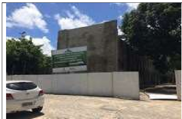
Foto 1 – Obra paralisada do Bloco 917 do Departamento de Matemática do Centro de Ciências - Campus do Pici da UFC - Fortaleza/CE, 02 de março de 2018.
