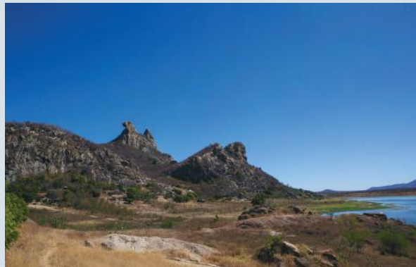
Açude Cedro, em Quixadá, é um dos que se encontram em alerta
