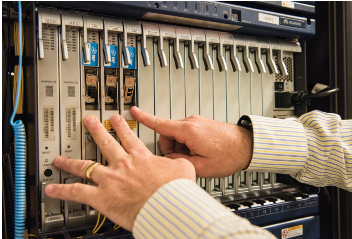
Sala de máquinas do Ponto de Presença da RNP no Ceará, localizada no Campus do Pici, que conecta o Estado à África, América do Norte e Europa
